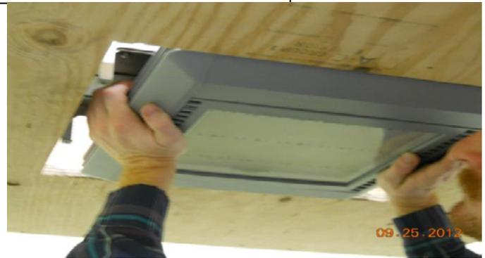
**ÉTAPE 7 : RETIRER LES MAINS DU LUMINAIRE ; IL DEVRAIT SE SUSPENDRE EN PLACE DE FAÇON SÉCURITAIRE. SUR CHAQUE CÔTÉ DU LUMINAIRE SE RETROUVENT DES ATTACHES DE VERROUILLAGE. EN UTILISER 2 no 8-32 x 1/2 PO POUR RATTACHER LE LUMINAIRE SUR LE DESSUS DU SUPPORT DE MONTAGE.**
